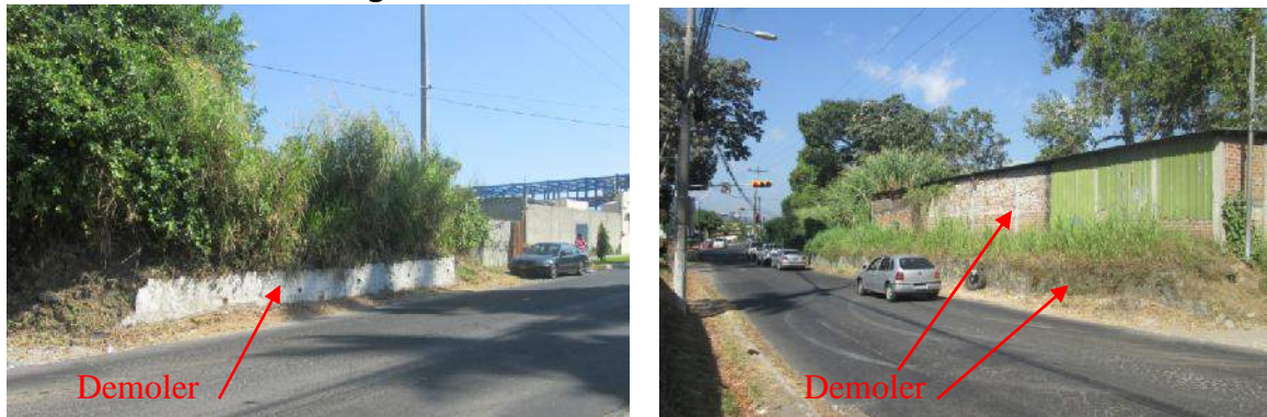
Figura 4-20 Vistas de estructuras a demoler
