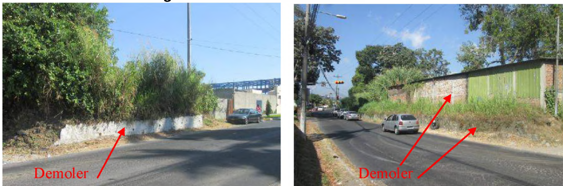
Figura 4-20 Vistas de estructuras a demoler
