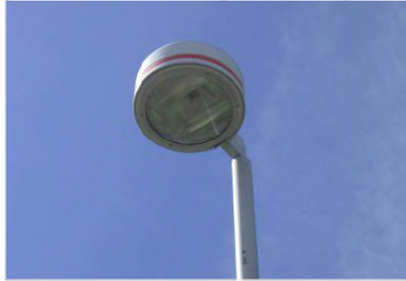
Figura 4-17 Luminarias a prueba de explosiones
