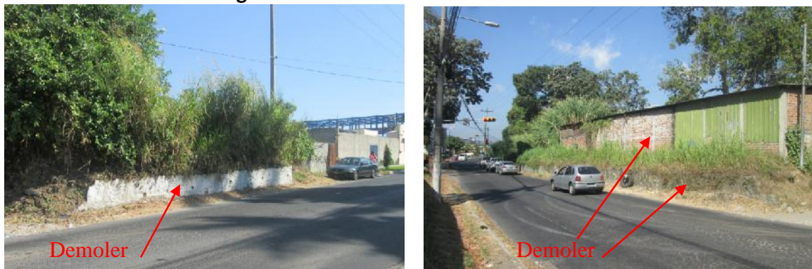
Figura 4-20 Vistas de estructuras a demoler
