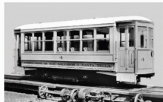
Tranvía operado por baterías
