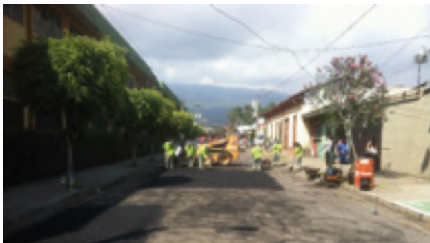
3ª Av. Sur y 6ª Calle Oriente.
