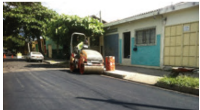
3ª Av. Sur y 8ª Calle Oriente.
