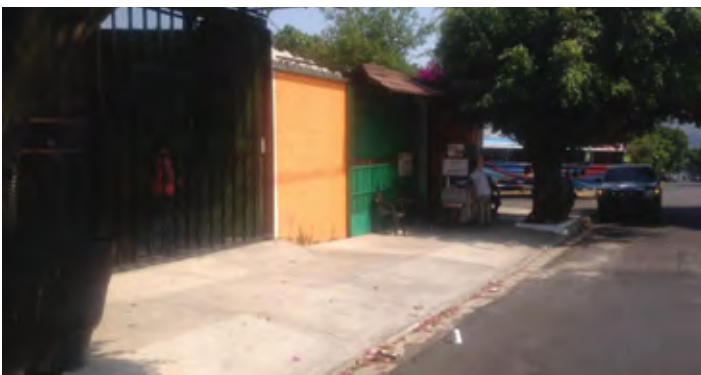
Construcción de acera entre la 12 a avenida Norte y calle San Antonio, polígono "Q", colonia San Antonio Las Palmeras: 15 m 2
