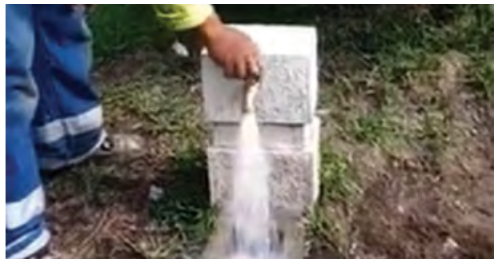
Mejoramiento de red de agua potable, habilitación del sistema de bombeo e instalación de 11 grifos en parque San Martín.
