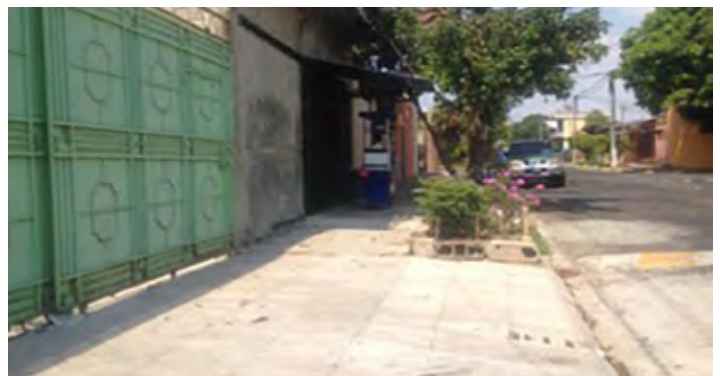
Construcción de acera entre la 10 a avenida Norte y 15 a calle Poniente, polígono "Q", colonia San Antonio Las Palmeras: 65 m 2 .
