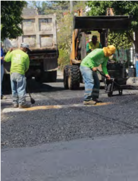
25 REMDELACIÓN Y CONSTRUCCIÓN DE OBRAS
