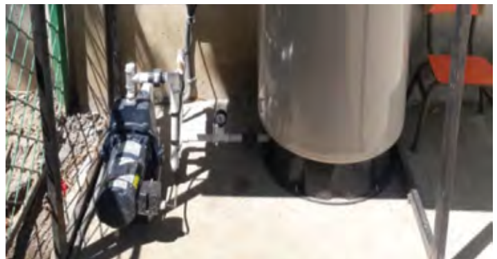
Instalación de sistema de agua potable, instalación de muro prefabricado en CAMST en El Cafetalón
