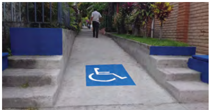
Construcción de rampas en Jardines del Volcán.
