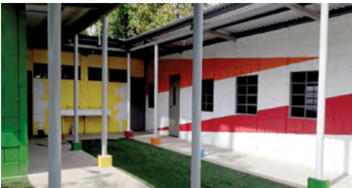
Construcción del Centro de Atención Integral de Niñez y Adolescencia de comunidad El Progreso y casa comunal de residencial Los Cipreses
