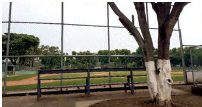
Diamante de béisbol El Cafetalón, construcción de 72 m 2 de acera, rampa y graderíos metálicos
