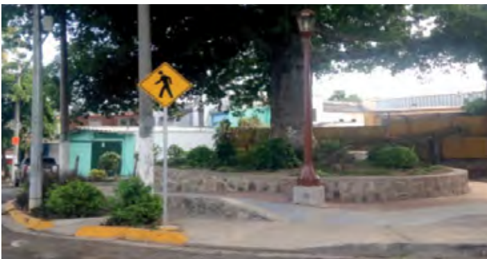
Construcción de plaza comunidad Las Margaritas, salida de Santa Tecla por la 7a. avenida Norte
