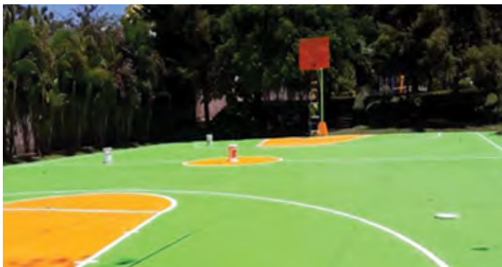
Mejora y pintura de cancha de baloncesto en la Residencial Buena Vista #2
