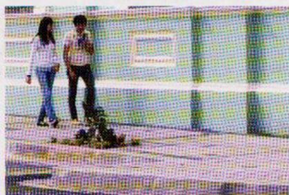
Recuperación total del sistema de aceras municipales.
