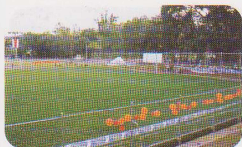
Construcción de Cancha 8 en El Cafetalón
