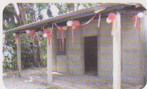
Construcción de casas en Cantón Sacazil
