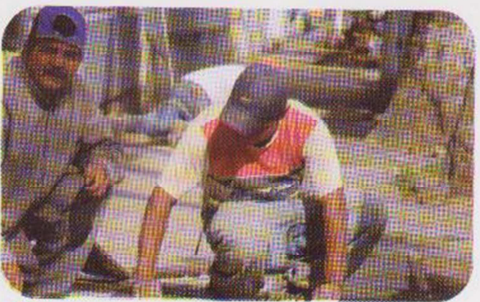
Recuperación de aceras y arriates
