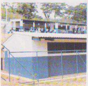
Vallas de protección
