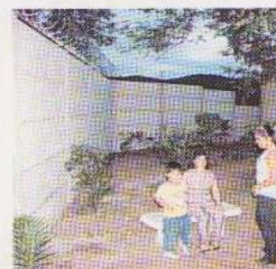
Construcción de muro perimetral
