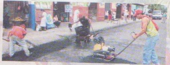
Brigada municipal de bacheo en plenas labores
