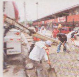
Ampliación de parqueo en Plaza Dueñas
