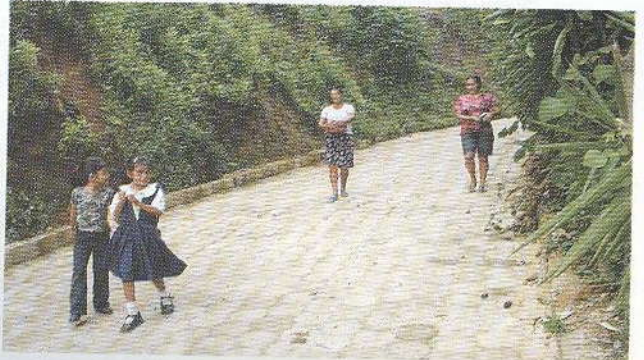
Adoquinado de caminos vecinales en zona sur, cantón Granadillas.
