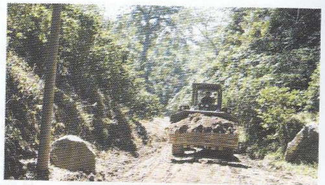
Construcción de nuevos caminos rurales en zona norte, cantón Victoria.
