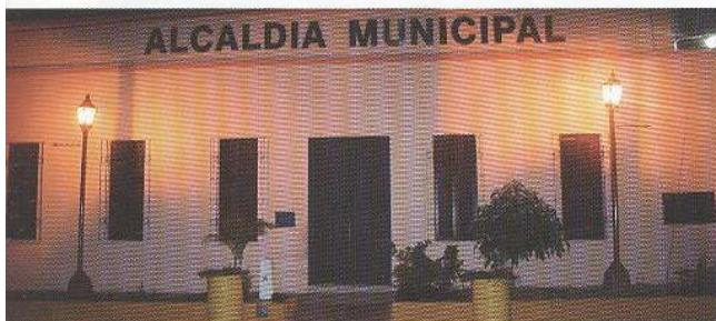
Fachada del nuevo Palacio Municipal.
