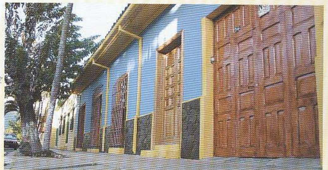
Fachadas antiguas restauradas en la 2a. Av. Nte.
