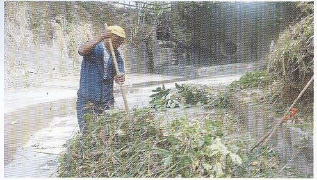
Trabajos de mantenimiento en quebrada El Piro.
