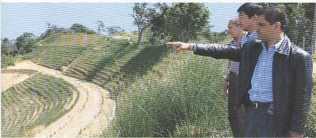
Inspección a los trabajos de mitigación en lo alto de la Cordillera del Bálsamo.
