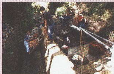
Introducción de agua potable a Cantones y Comunidades.
