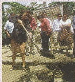
Construcción de viviendas con ayuda mútua.
