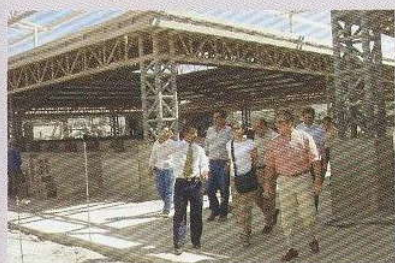
Cooperantes de la región de Cataluña, España, recorren obras del municipio.
