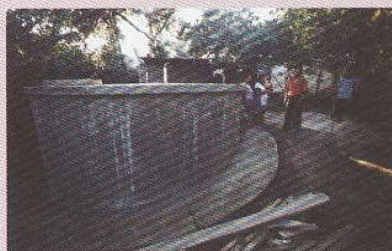
Construcción de Tanques de Captación de agua
