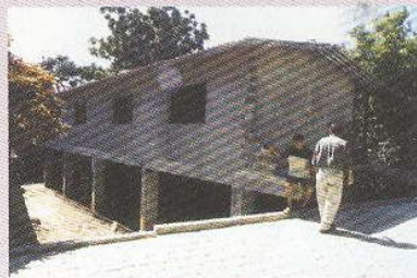
Construcción de Clínicas Comunes.
