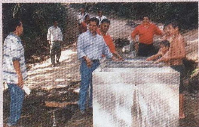
Construcción de lavaderos públicos en cantones.
