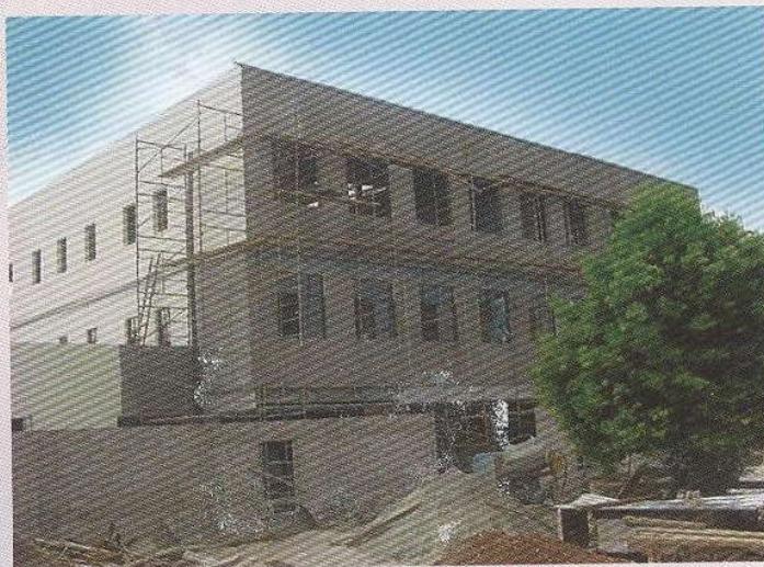
Edificio de la Alcaldía Municipal en construcción.
