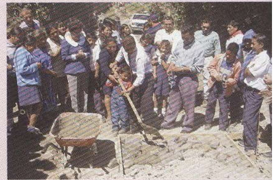
Ejecución de obras en zona norte del municipio.
