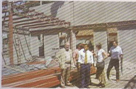
Construcción de la nueva Alcaldía Municipal.
