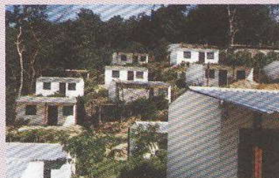
Construcción de viviendas permanentes.
