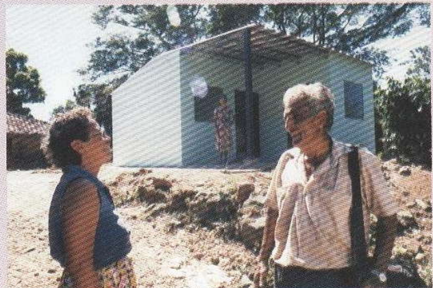
Construcción de viviendas permanentes en cantones.
