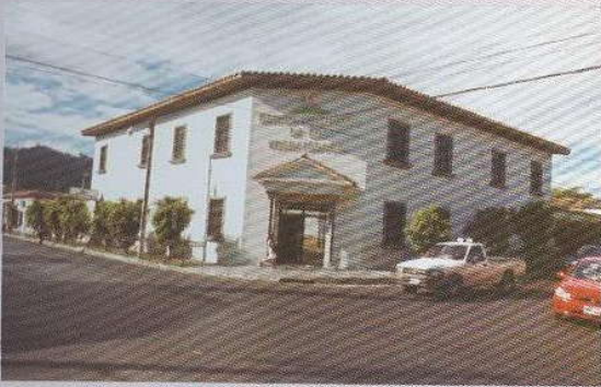
Preservación del legado arquitectónico Colonial.
