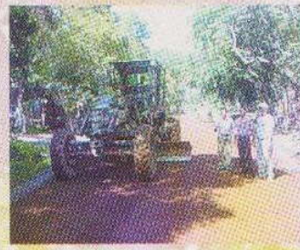
Mejoramiento e iluminación de pista perimetral "El Cafetalón".
