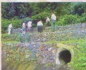
Obras de mitigación en la Cordillera del Bálsamo.
