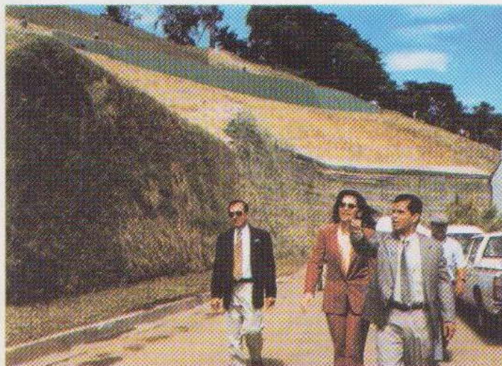
El alcalde Oscar Ortiz inspecciona obras de mitigación.
