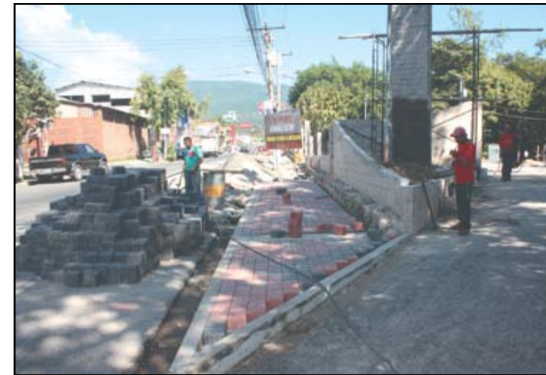
Nuevo Parqueo El Cafetalón
