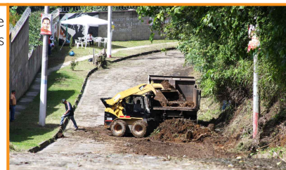
Mantenimiento de Caminos Vecinales
