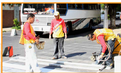
Señalización y Ordenamiento Vial
