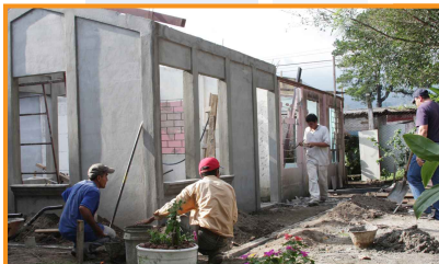
Proceso de Construcción del Observatorio Municipal de Prevención del Delito.
