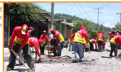
Unidad de Mantenimiento Vial en Acción
