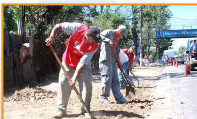
Obras de construcción de Arriatas zona ITCA.
