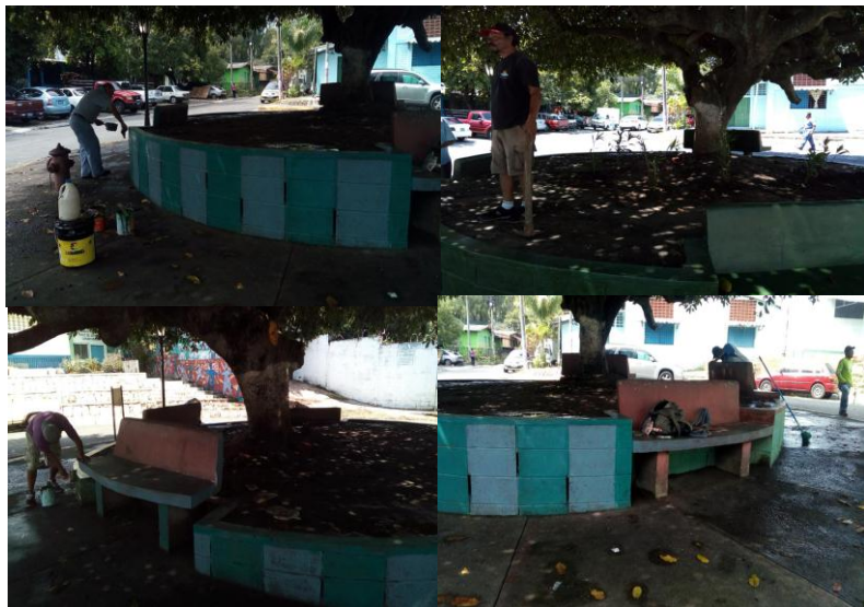
12/08/2019: Restauración de Redondel del Pino
