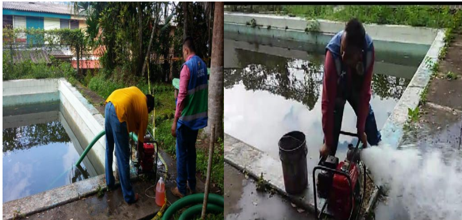
22/10/2019: Se limpió Piscina de Casa Guirola Ubicada en Residencial El Paraíso.
